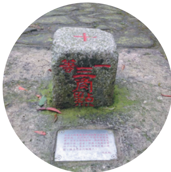
大尖山雖然海拔不高，但是仍有一等三角點的絕佳視野，而且還有一等衛星控制點喔！
