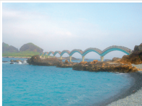
三仙台一八拱跨海步橋
