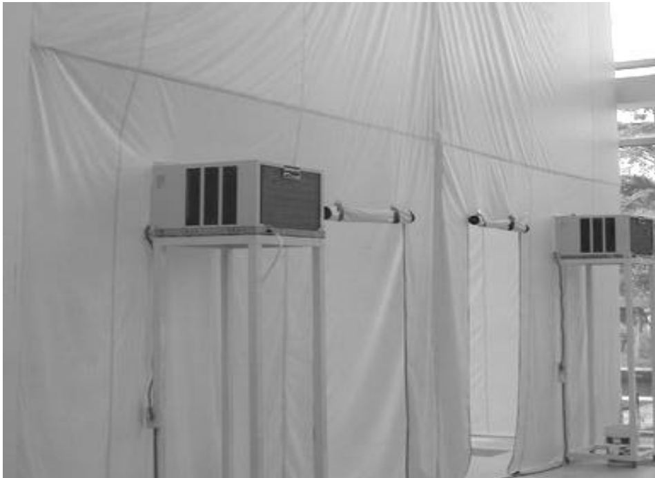
圖 2-2 完工後的實驗室外觀
