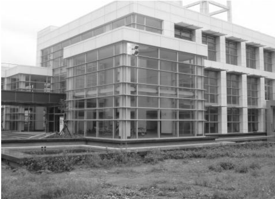
圖 2-1 內政部建築研究所性能實驗群中庭側面
