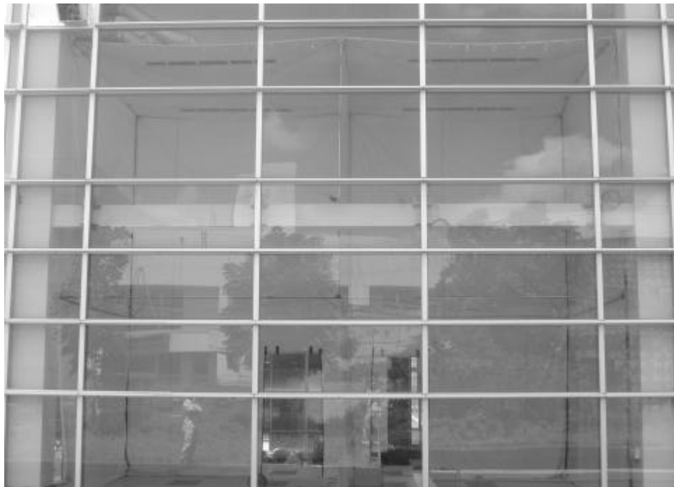
圖 2-4 完工後的實驗室玻璃面
